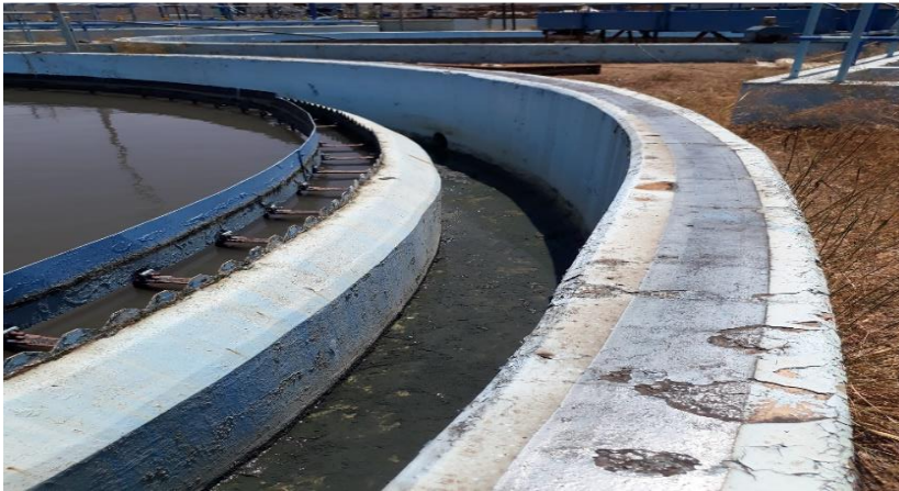
Figure (II.7) : Le déflecteur à bord dentelés
