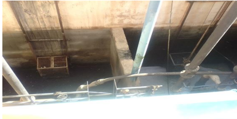
Figure (II.2) : L'étape de dégrillage des eaux usées industrielles et sanitaires séparément
