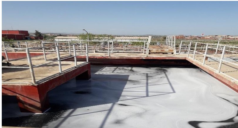
Figure (I.9) : Bassin d'aération du complexe de Textile SOITINE - Nedroma –
