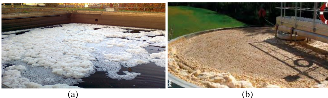
Figure (I.17) : Phénomène de moussage dans une station d'épuration : (a) : moussage blanc, (b) : moussage brun [24]
