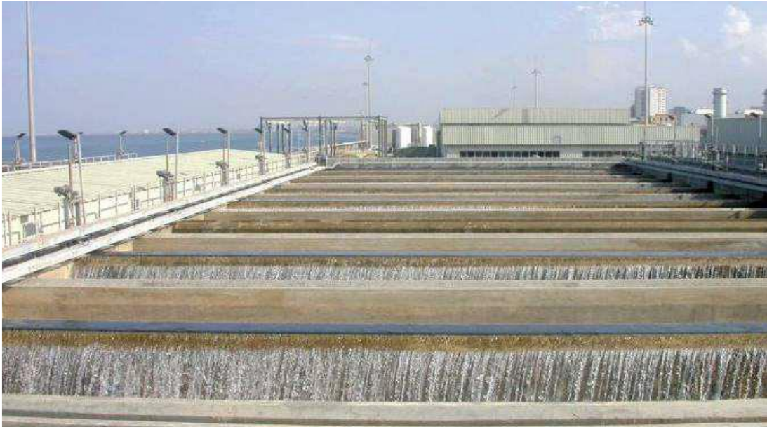
Figure IV. 2 : passage de station de dessalement de Souk Tlata. (11)
