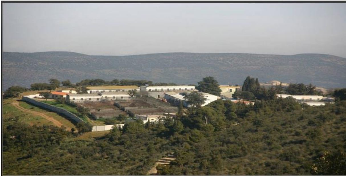
Figure 16 : centre cynégétique de Tlemcen
