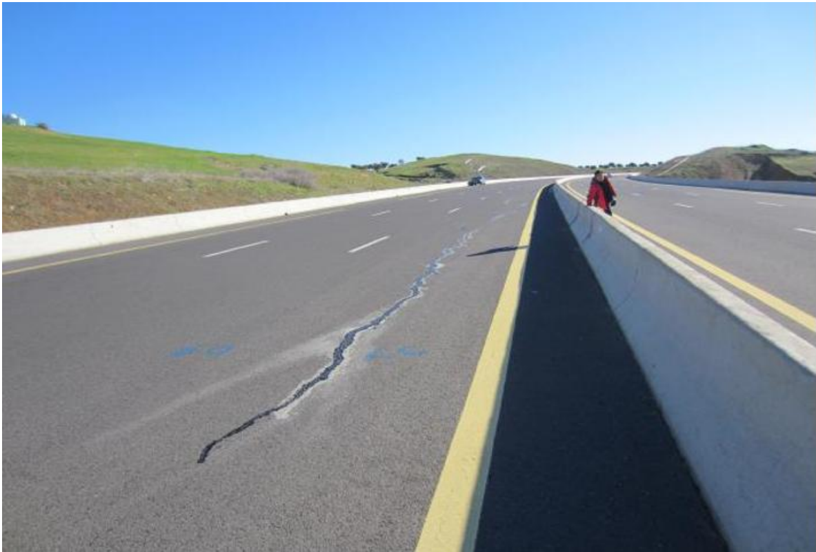
Photo 3.2 : Fissure sur la chaussée du côté gauche au PK 45 de l'autoroute
