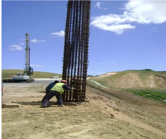
Photo 3.6 Pose du ferrailage et bétonnage du pieu (25-04-2014)
