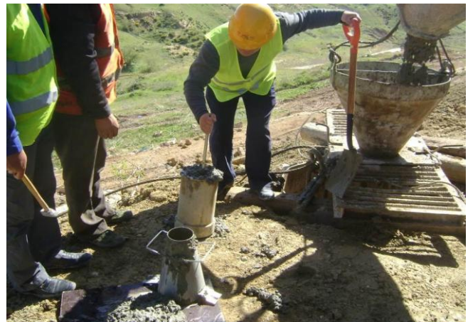
Photo 3.5 remplir du pieu N°67' au PK45+800
