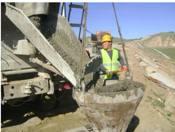
Photo 3.4 Bétonnage du pieu N°67' au PK45+80
