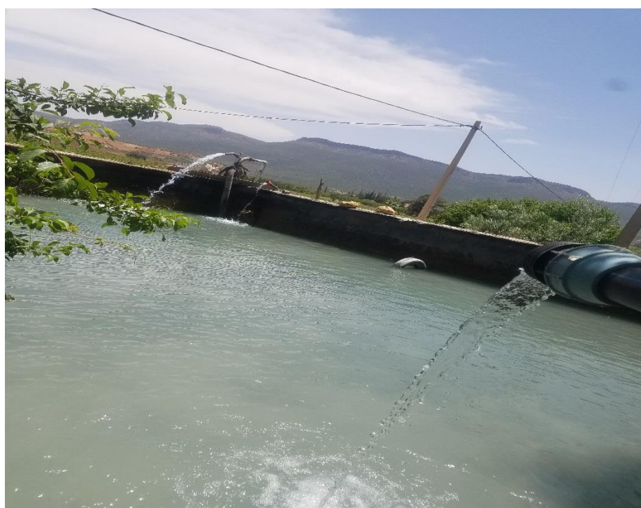
Photo n°5: infrastructure hydro-agricole «bassin en dur» (originale)
