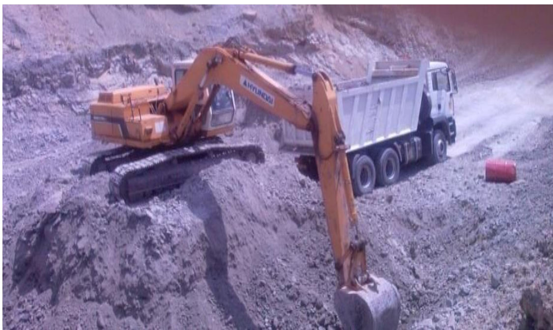
Fig. 12- Chargement et transport
