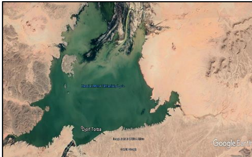
Figure 25. Prise satellitaire par Google Earth pro du barrage de Djorf El Torba (Web.2)
