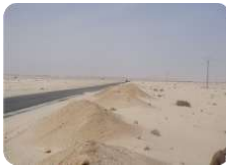
Figure 20. L'efficacité des Drâas implantés en biais sur la route Touggourt-Djelfa (d'après Sebaa et al., 2015).
