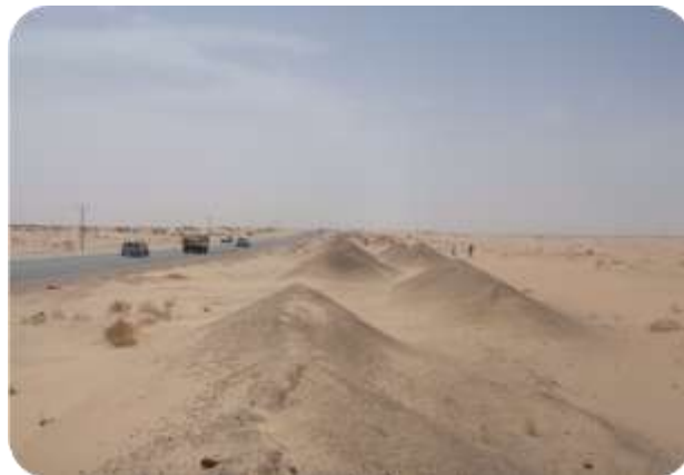
Figure 19. L'efficacité des Drâas en chicane appliqués sur la route nationale RN3 (Touggourt-Ouargla) (d'après Sebaa, 2015).
