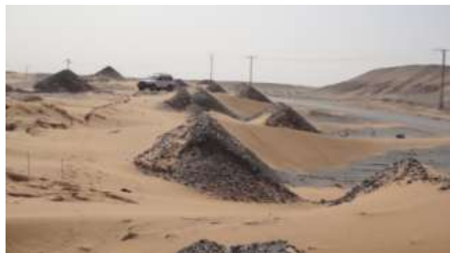
Figure 41 (a, b, c). Photos prises le 14 Novembre 2016, montre l'efficacité des Drâas à protéger la chaussée contre l'ensablement après une année des vents violents (d'après Sebaa, 2016).
