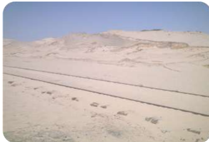
Figure 2. Epannage de dérivés de pétrole (bitume) pour protéger la voie ferrée contre l'ensablement (Biskra_ Touggourt) (Sebaa et al., 2015).
