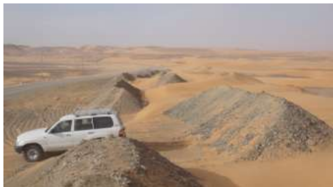
Figure 38. Vue générale d'une zone stabilisée mécaniquement par la technique des Drâas à Adrar (d'après Sebaa, 2016).
