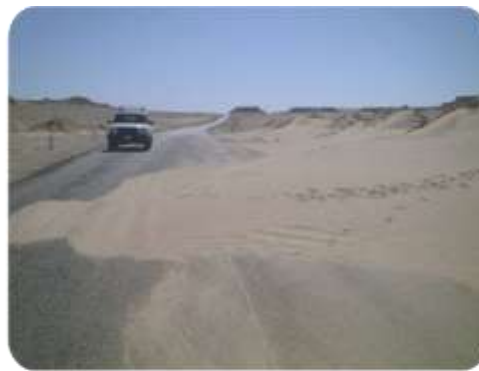
(b) Dunes mobiles provoquant l'ensablement de la route Touggourt vers Djelfa
