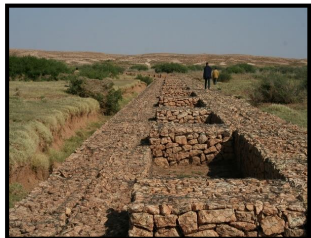
Photo 15 : Ouvrages en gabions (Originale) : C'est des ouvrages réalisés à base de gabions pour la mobilisation et la récupération des eaux de surface.
