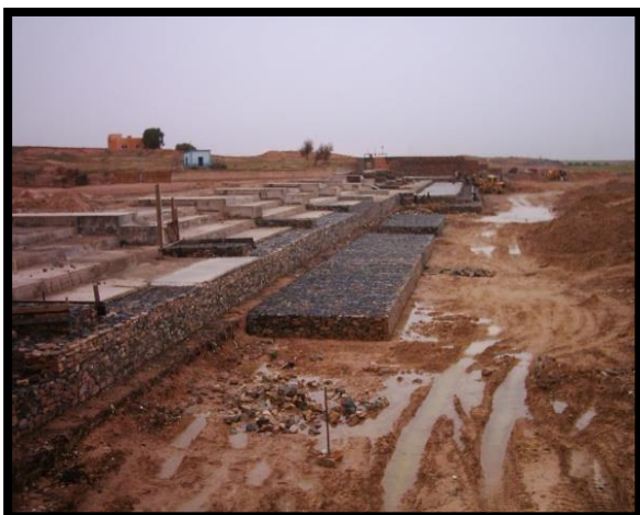
Photo 15 : Ouvrages en gabions (Originale) : C'est des ouvrages réalisés à base de gabions pour la mobilisation et la récupération des eaux de surface.
