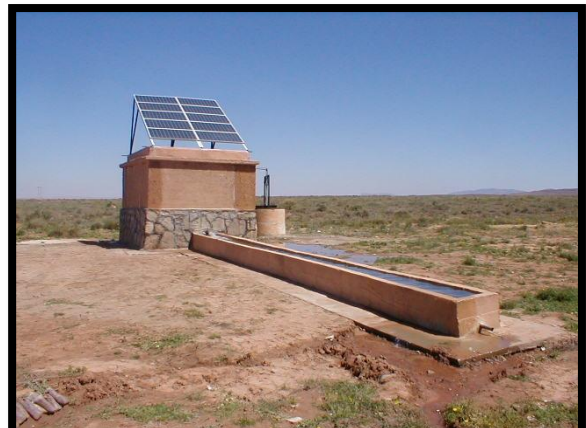
Photo 14 : Réalisation d'un forage équipé par l'énergie renouvelable (W. de Djelfa) (Originale)
