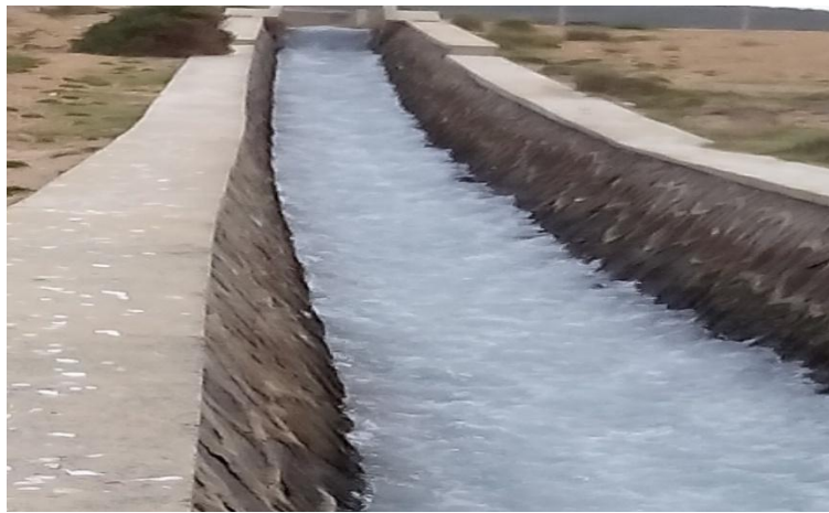
Figure 47 - Effluents de la ferme aquacole se déverse en mer (Originale)
