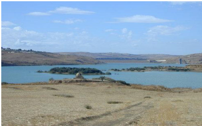
Photo 05 : Vue lointaine du barrage Sidi-Abdelli . (Ghomri et Mahammed, 2017).
