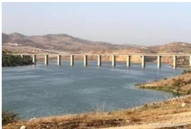
Photo.02 : Vue de face du barrage de Hammam-boughrara. (Ghomri et Mahammedi .2017)
