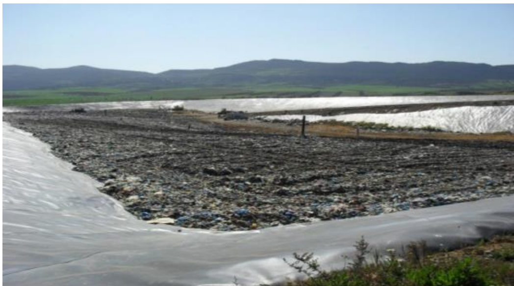
Figure 12: Remplissage des casiers
