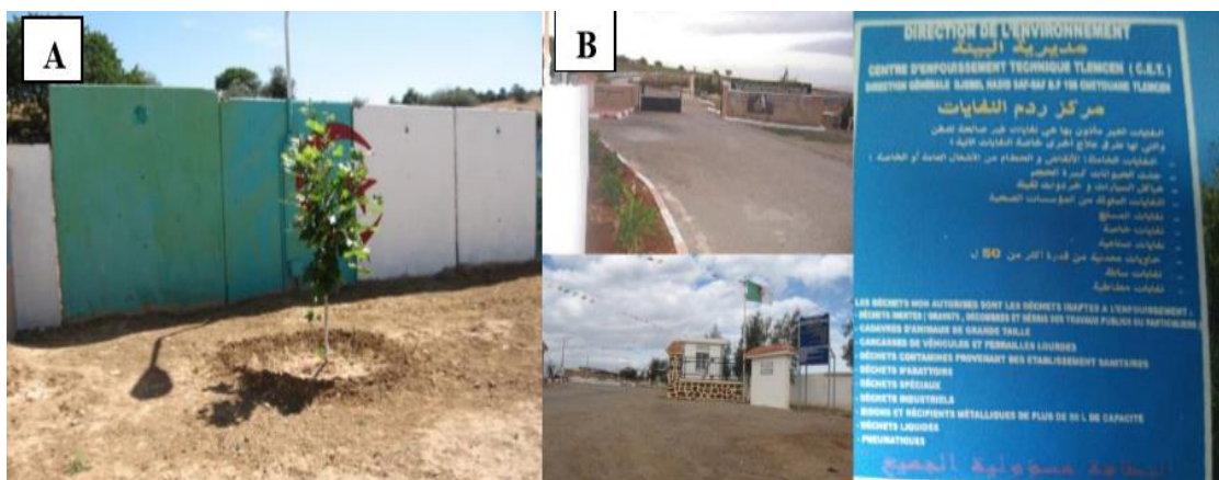
Figure 8 : A : Clôture ; B : Les deux Portails
