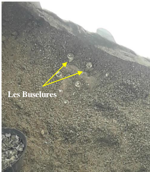
Fig.31 : Les Busetures (Photo prise par M lle . F. BOUALI & M lle . A. BRAHIM au niveau de la station de traitement Sekkak, Tlemcen, le : 04/04/2021).
