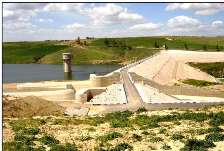
Fig. 12 : Barrage Sekkak (Photo prise par M lle . F. BOUALI & M lle . A. BRAHIM au niveau du barrage Sekkak, Tlemcen, le: 27/05/2021)
