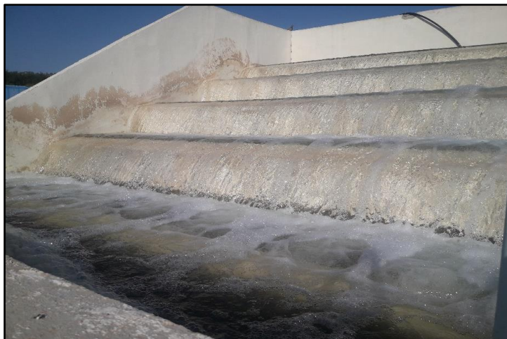
Fig.26 : Cascade d'aération (Photo prise par M lle . F. BOUALI & M lle . A. BRAHIM au niveau de la station de traitement Sekkak, Tlemcen, le : 04/04/2021).
