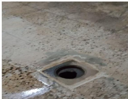
Figure 17 : Photo montrant un Siphon non couvert à l'intérieur du couvoir.
