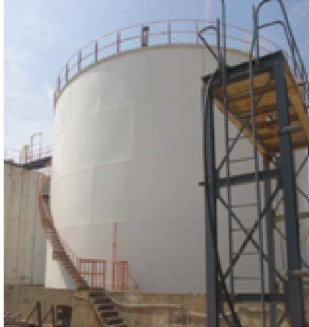
FIGURE 1.3 – Tank de stockage d'acide sulfurique. [11]
