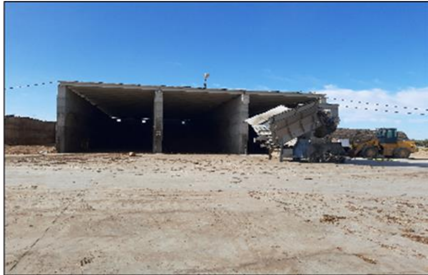
Figure 17: : Les trois bunkers de fermentation successives de composte
