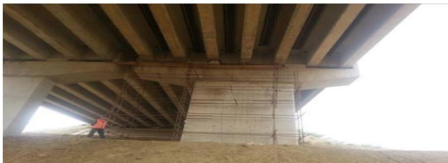
**Figure3- 11-Installation des échafaudages**
