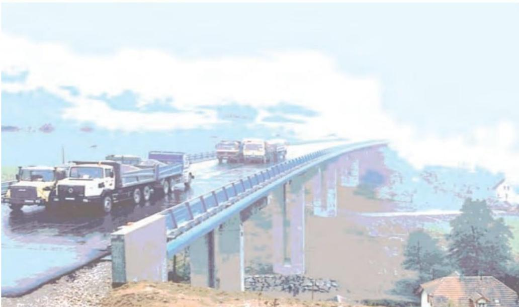
**Figure1- 1-Epreuve de chargement des ouvrages d'art**
