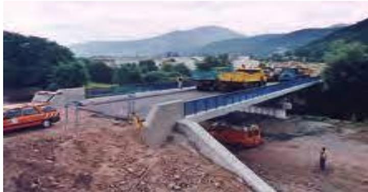
**Figure1- 5-Chargement d'un appui**
