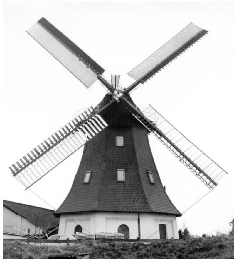
Figure I.3-Moulin à vent (moulin à vent terrestre hollandais) avec voiles à ressort [4].
