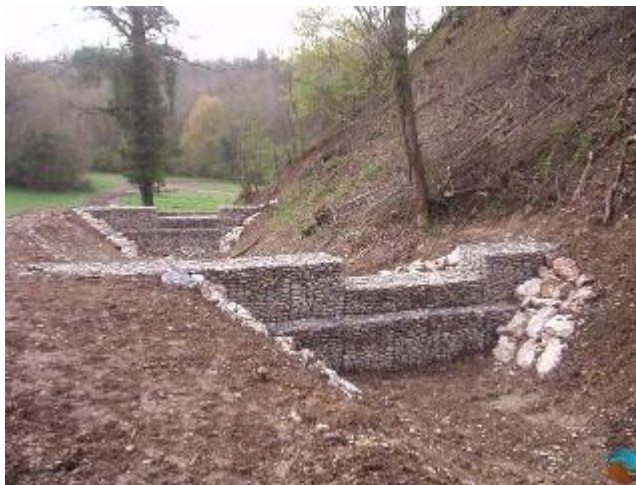
Figure 09 : Seuil en gabion 5
