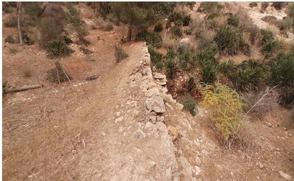
Photo 6 : seuil en gabion stable avec grillage coupé et volé avec un atterrissement de 100% (Cliché Zékri et El-Bordji, 19 juin 2021)
