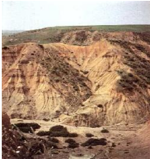
Figure 4 : érosion par ravinement 2
