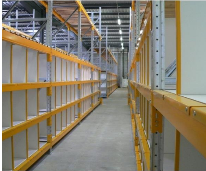
Figure 1. 5 Une allée séparant deux racks de stockage prise du site de l'entreprise provost
