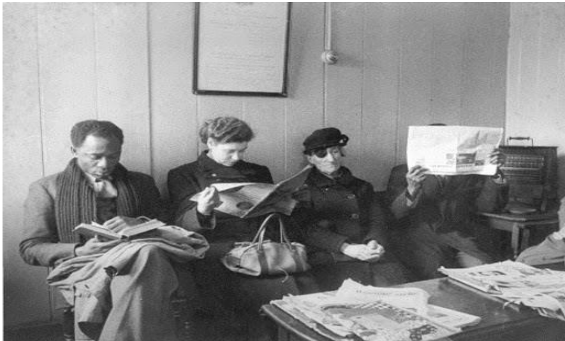
Figure I.1 : salle d'attente d'un hôpital en 1950
