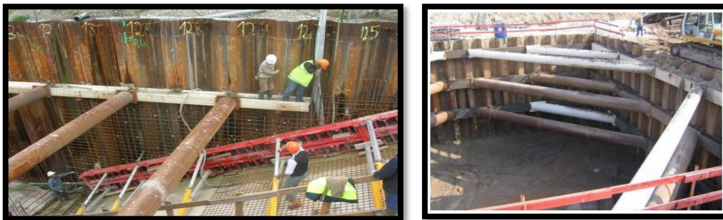
Fig I.31. Exemples de l'utilisation des butons
