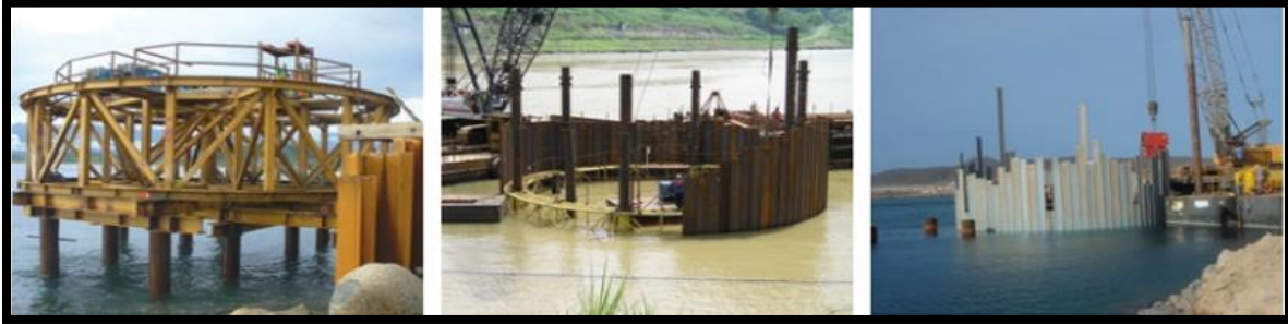
Fig I.20. Installation du gabarit Fig I.21. Enclenchement des palplanches Fig I.22. Fonçage Jusqu'à la Fermeture du gabion
