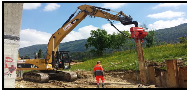
Fig I.38. Chantier de battage de palplanches
