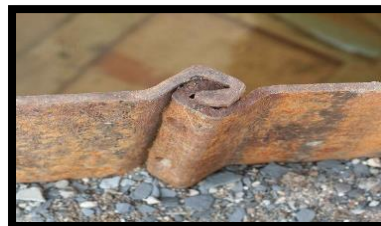
Fig I.26. Serrure à la jonction de deux palplanches
