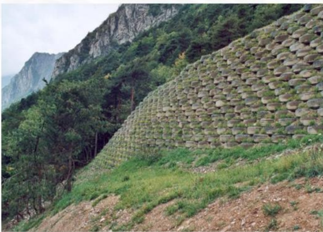
Figure 2.14a : Merlon Bourg d'Oisan 2 – Mur pare bloc – 6000 pneus découpés sur un flan.
