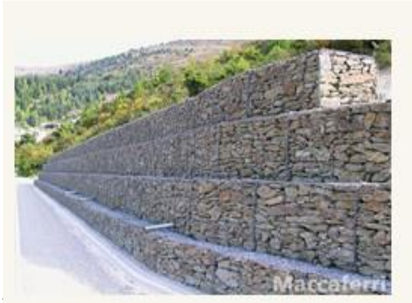
Figure 2.19. Exemple de mur gabion
