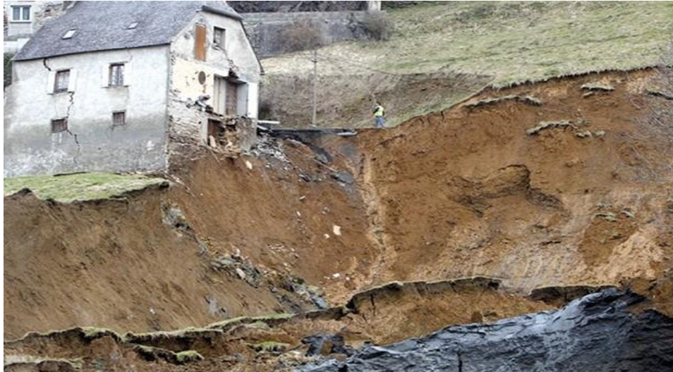
Figure 1.21. Glissement de terrain à La wilaya de Guelma
