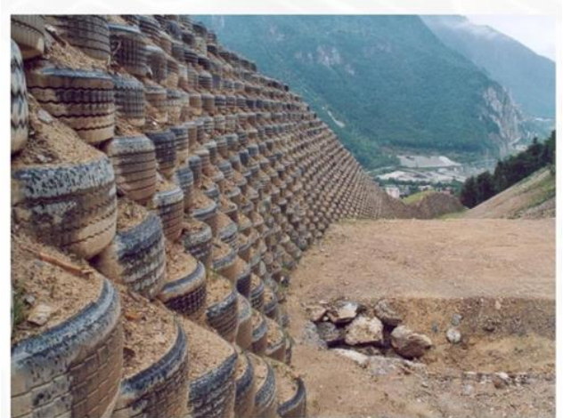
Figure 2.14b : Merlon de Moutiers, mur pare bloc – 8000 pneus découpés sur un flan.
