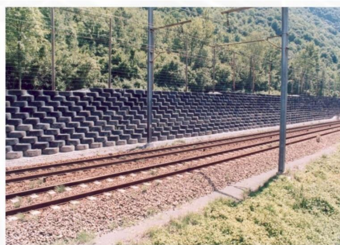
Figure 2.14c : Merlon pour la SNCF – Saint Jean de Morienne – 2000 pneus découpés sur un flan.
