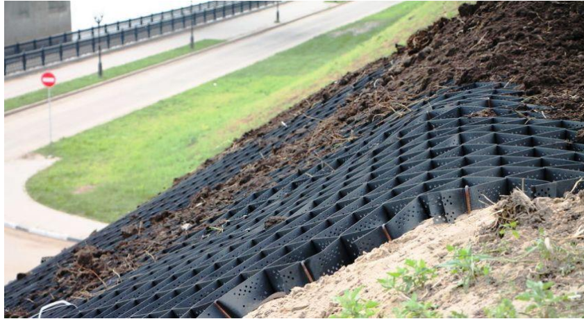
Figure 2.12. Renforcement par géotextile tridimensionnel (prise site web conceptual house plans)
