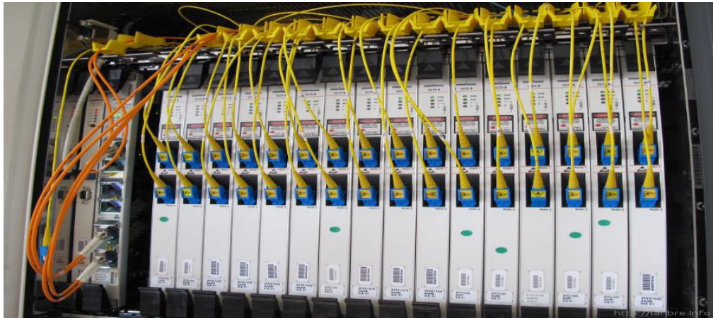
Figure I .17: Ligne optique terminal OLT.
