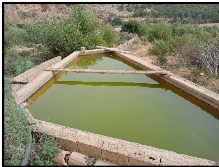
Figure n°35 : photo du bassin de site 2 Beni Bahdel ( photo original )
