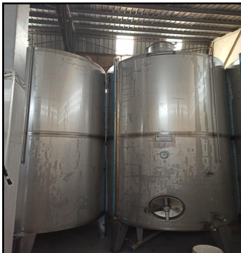
Photo 27 : Citernes en inox pour le stockage de l'huile (Huilerie d'Ouzidane)
