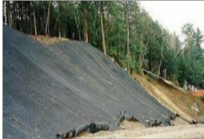
Figure 2.18 1Renforcement par géo-synthétiques (Nemmiche & Ougherb, 2015)
