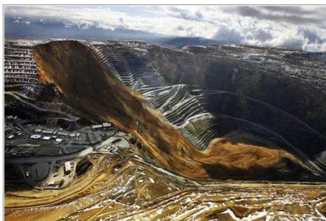
Figure 2.6 Glissement du terrain (Julien. 2017)
