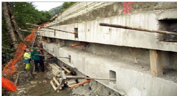
Figure 2.19 Renforcement par ancrage Chafi (2012)
