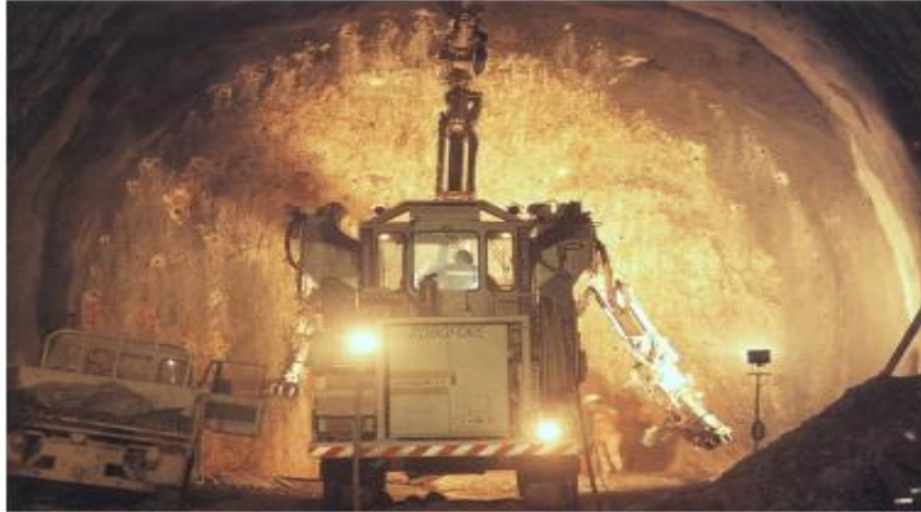
Figure 1.8 Jumbo sur le tunnel des penes-Mirabeau (TGV Méditerranée). Doc Eiffage cité par Martin (2012)
