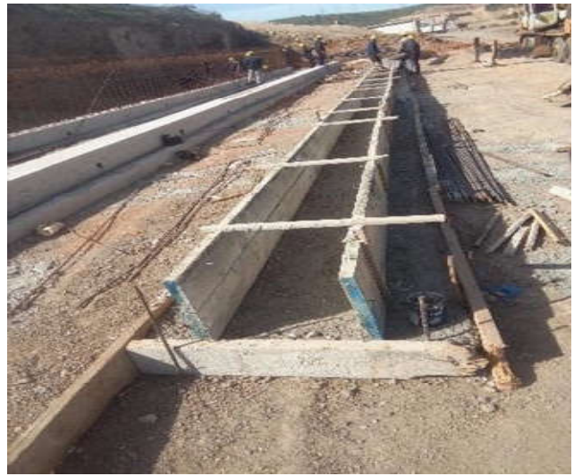
Photo 4.9 : Réalisation du socle de poutre
