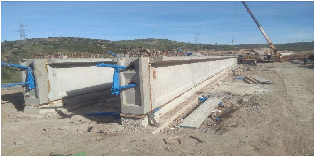
Photo 4.16 : Poutre précontraintes après décoffrage
