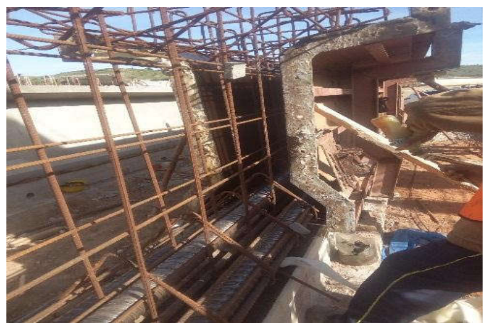
Photo 4.14 : Pose du coffrage de la poutre précontrainte
