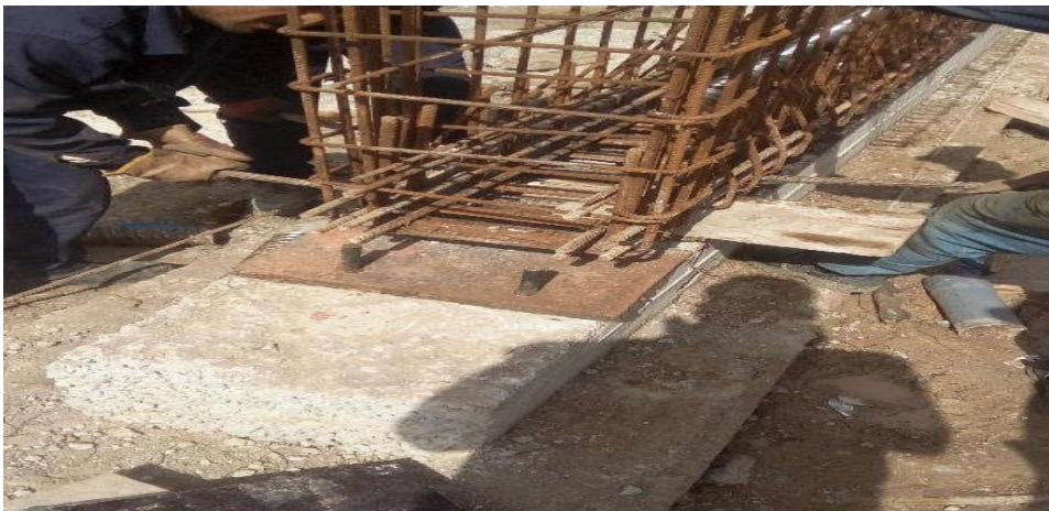
Photo 4.11 : Pose des socles d'appuis
