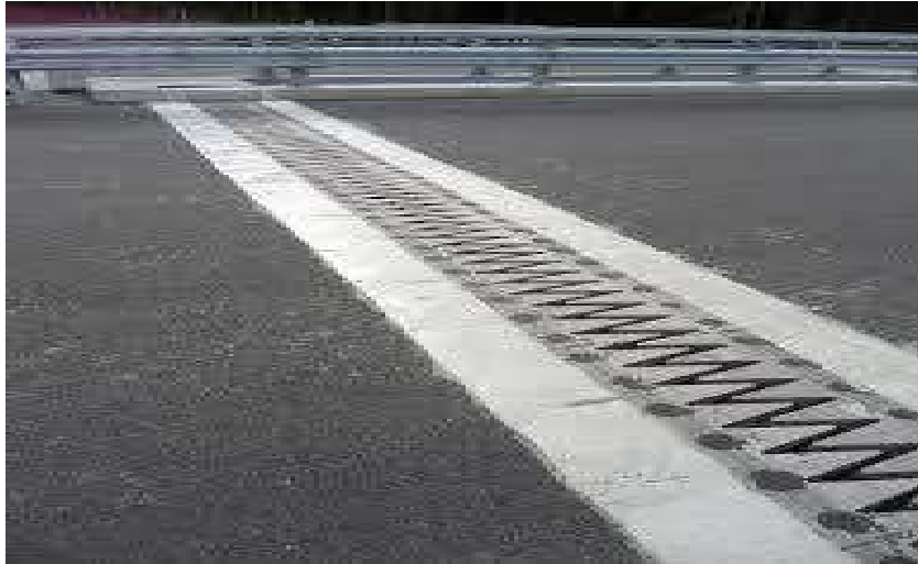
Photo4.18 : Pose des joints de chaussée.
