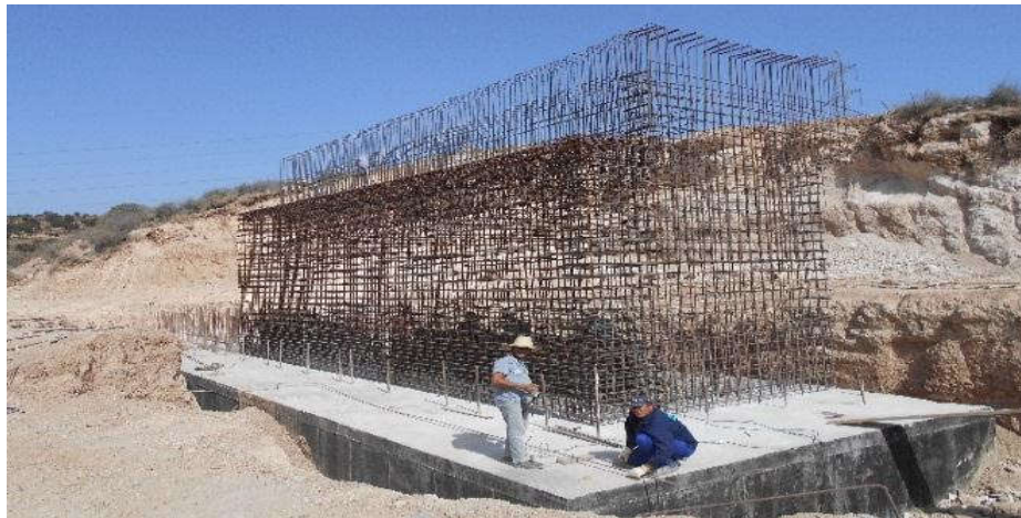
Photo 4.5 : mise en place du ferrailage de la culée
