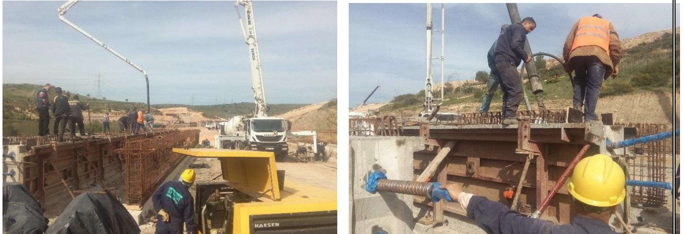
Photo 4.15 : Coulage de la poutre précontrainte
