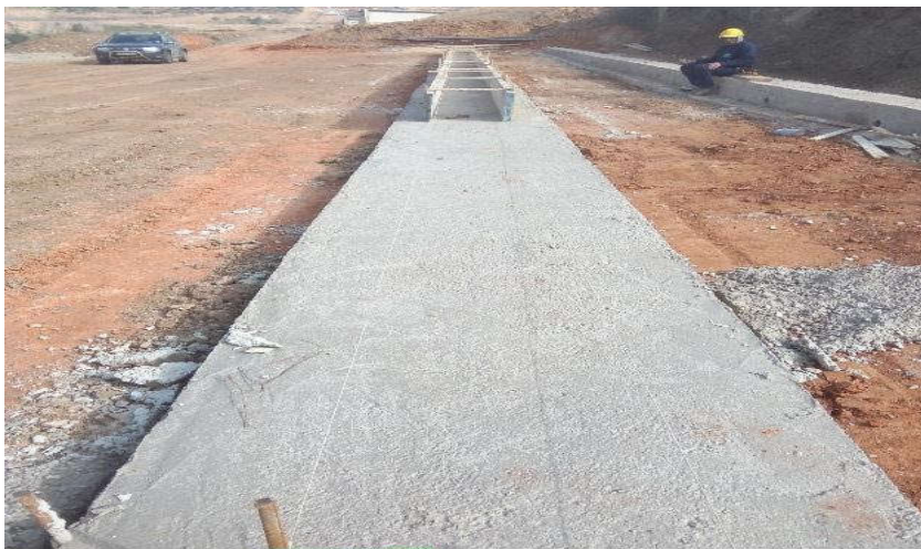
Photo 4.8 : Pose du béton de propreté
