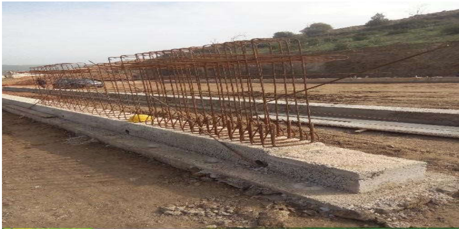
Photo 4.9 : Réalisation du socle de poutre
