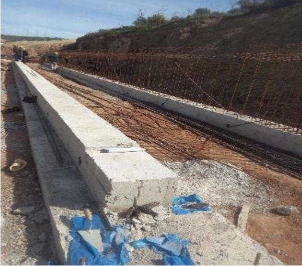
Photo 4.9 : Réalisation du socle de poutre
