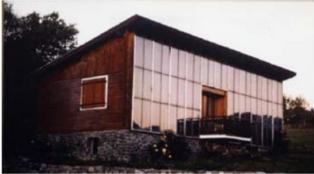
Figure 1.3 : Maison Trombe à Odeillo.
