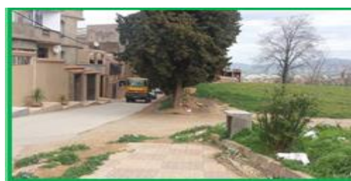
voie piétonne non traitée.
