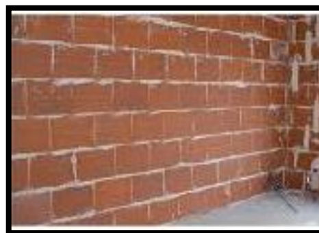
Figure 76 cloison en brique
