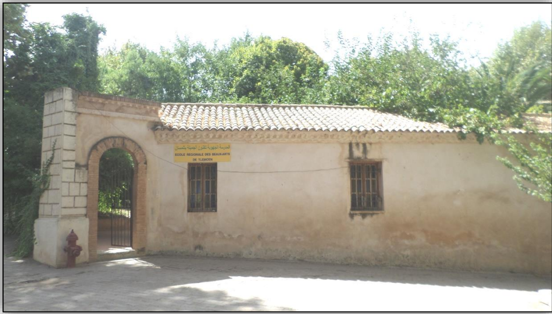
Photographie 94 : Constructions Coloniales Abritant Les Locaux De L'Ecole Régionale Des Beaux-Arts De Tlemcen (Ex Circonscription Archéologique).
