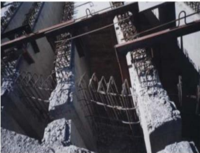
Figure 24: ferrailles des entretoises
