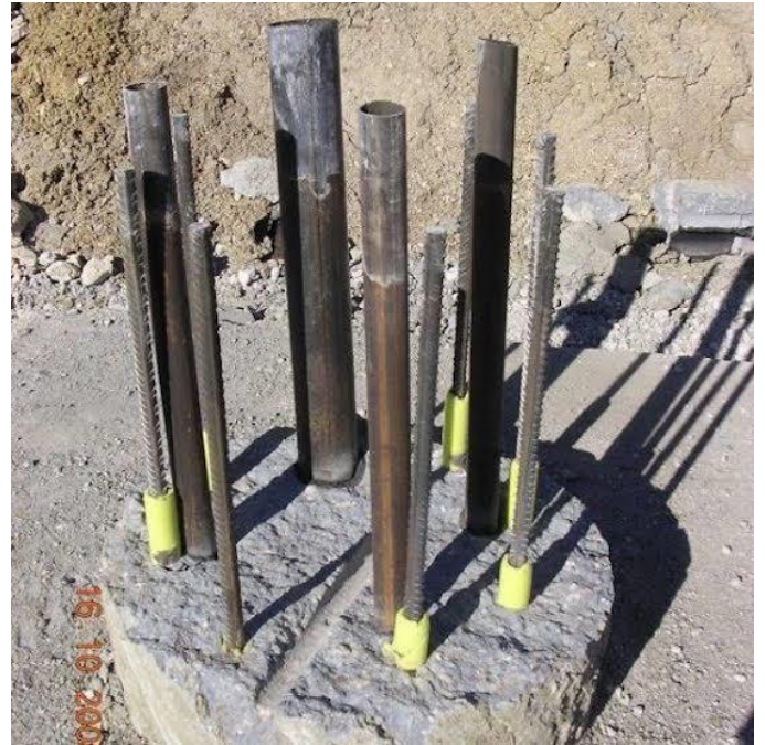
Figure 17 : Des tubes d'auscultation soniques
