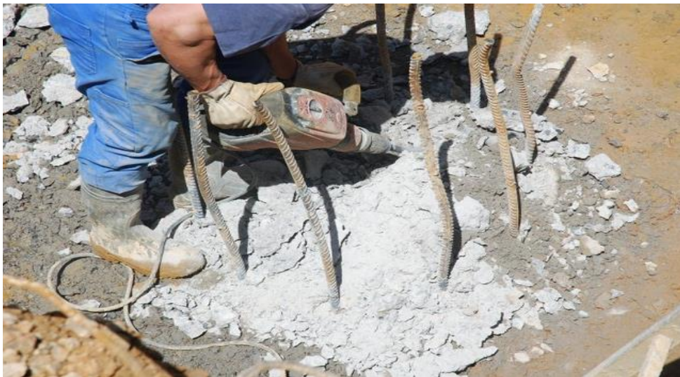
Figure 18: réalisation de semelle
