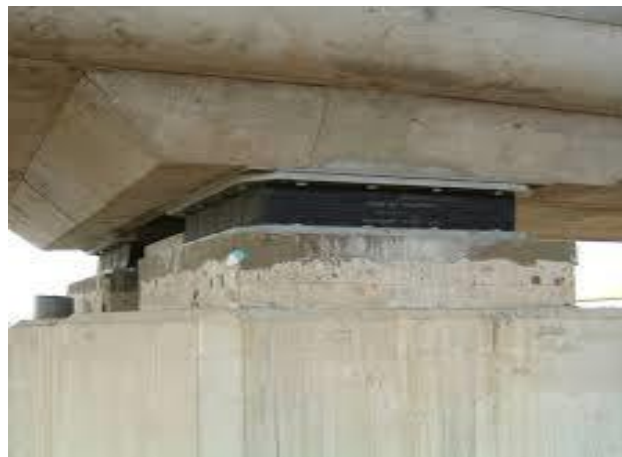
Figure 22: appareil d'appuis
