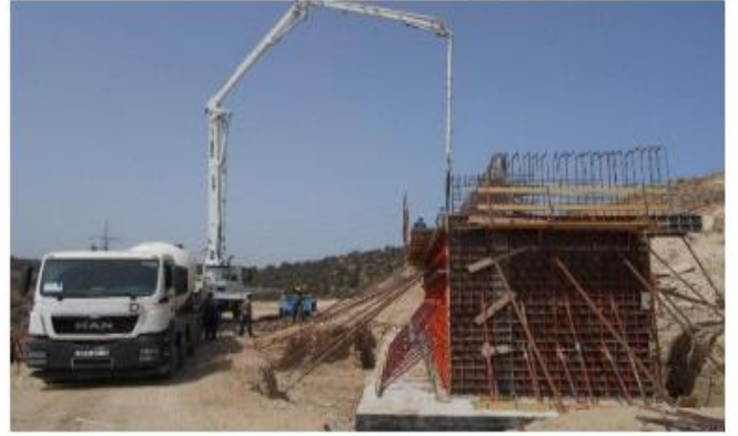
Figure 21: coulage de la culée
