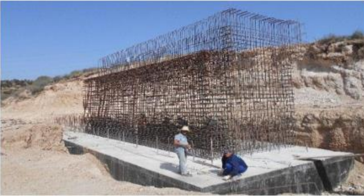
Figure 20: ferrailage de la culée
