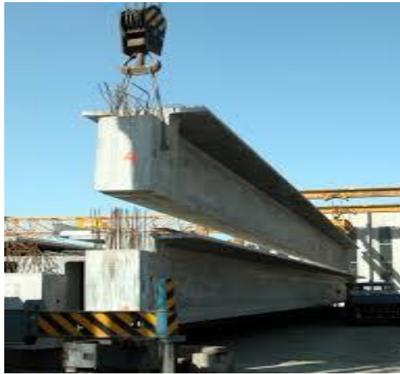
Figure 23 : pose d'une poutre préfabriquée
