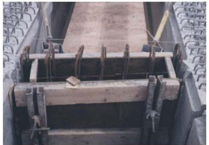
Figure 25: coffrages des entretoises
