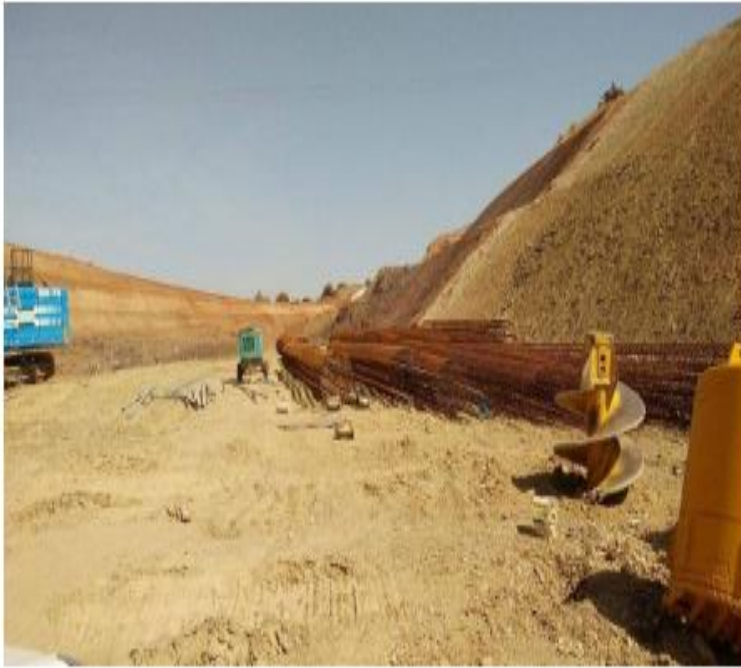
Figure 16 : ferrailages des cagesfigure
