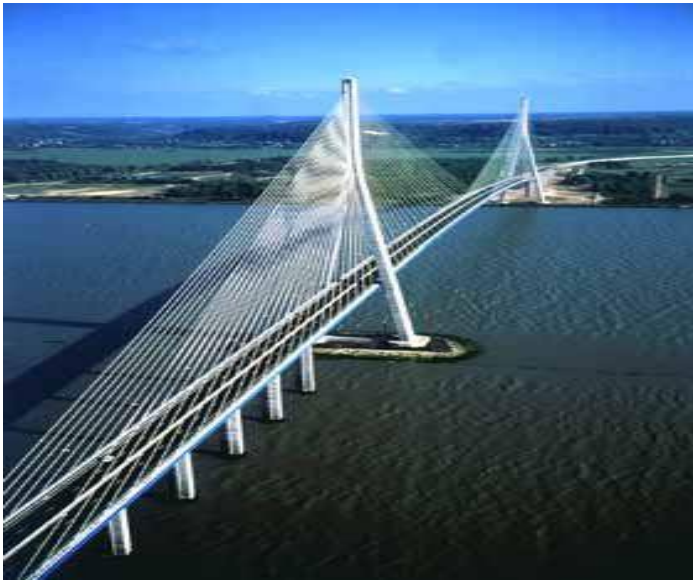
Figure 4 Pont à haubans de Normandie en France
