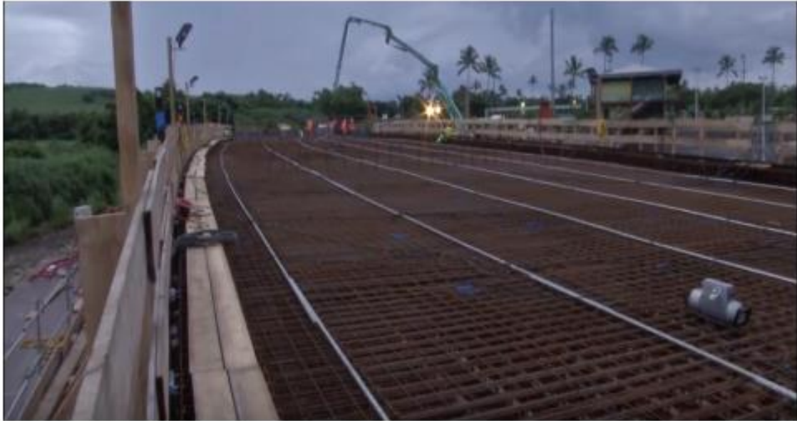
Figure 26:mise en place de ferrailages d'hourdis
