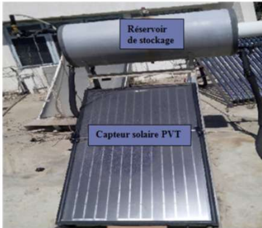
Figure. 2.9. Capteur PVT avec ballon de stockage [47].
