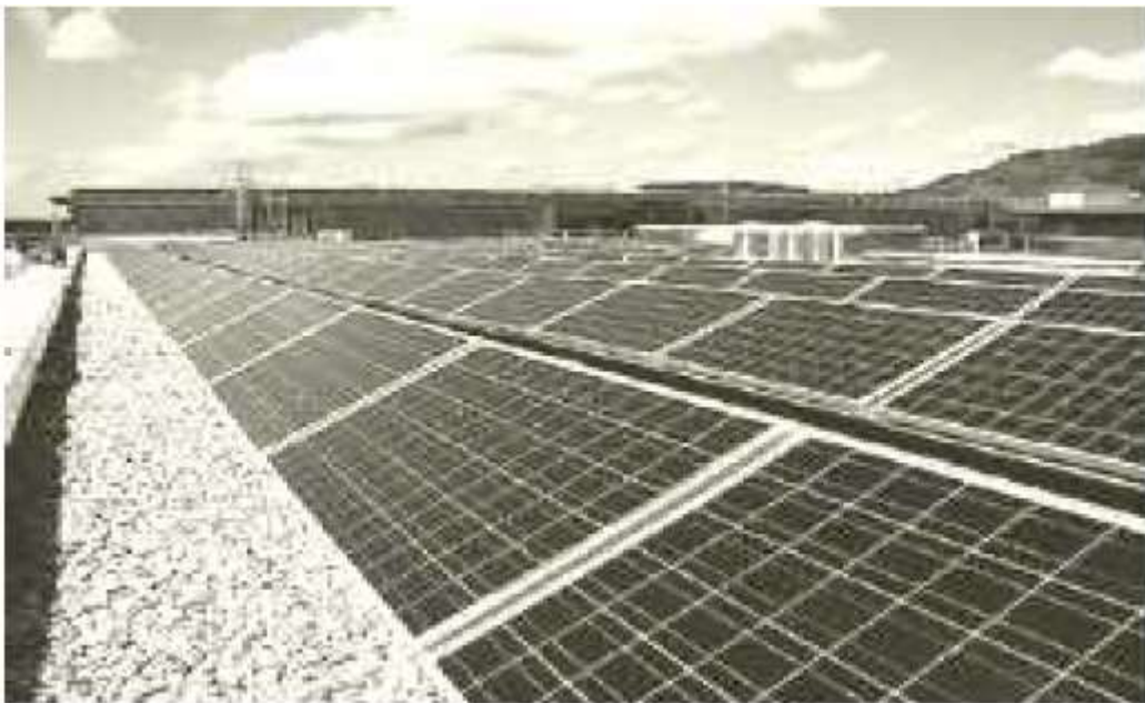
Figure 1.4 : Exemple de panneaux PV non-intégrés au bâti
