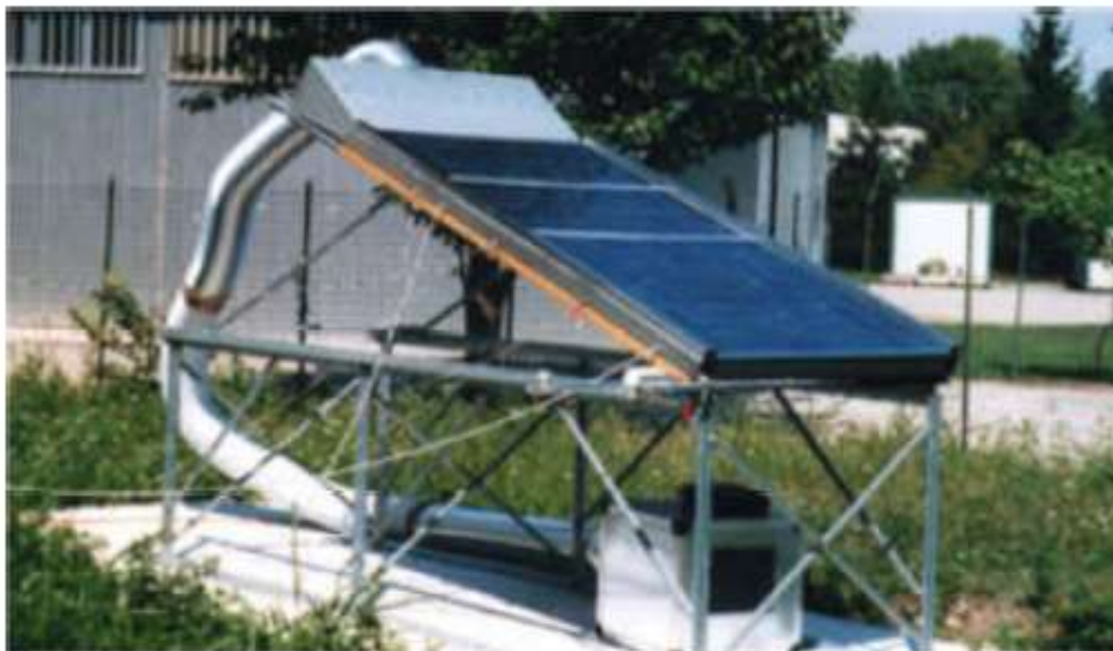
Figure. 2.12. Systèmes PVT avec circulation d'air [50].
