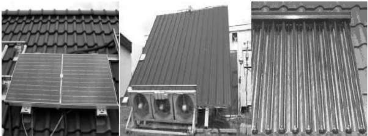
Figure 1.6 : Exemple de capteurs solaires plans vitrés, non vitrés et de capteurs solaires à tube sous-vide
