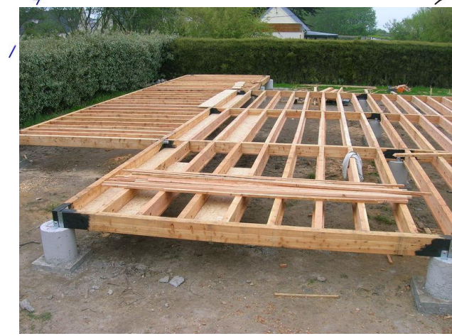
Figure 505 : planché en bois Source : http://pailienfinistere.canalblog.com/archives/2009/05/18/13777809.html
