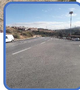
Figure 183: la rue ver Tounan Source : Auteur
