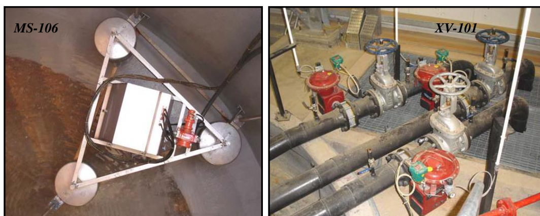
Fig.20 : Appareil tournant 'MS-106' et la vanne automatique 'XV-101'.
