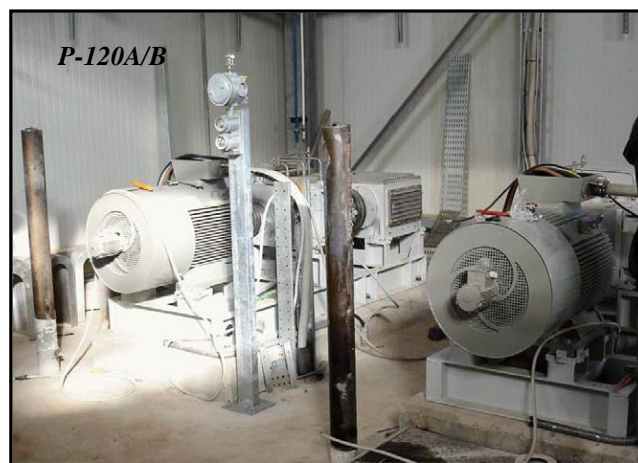
Fig.28: Les pompes d'injections.
