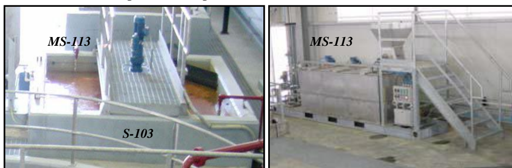
Fig.22 : Cuve de floculation 'S-103' munie d'un agitateur rapide 'MS-113'.
