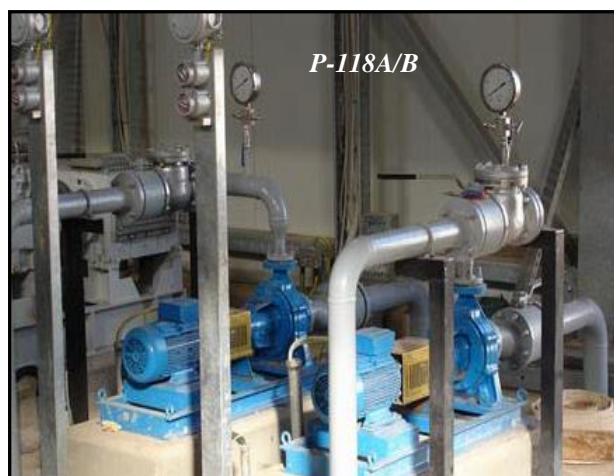
Fig.27: Les soufflants ' K-103 ' et les pompes de lavage ' P-118A/B '.
