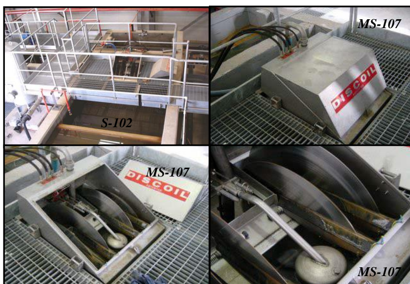
Fig.21 : Cuve de déshuilage primaire ' S-102 ' munie d'un disque rotatif ' Discoil ' ' MS-107 '.
