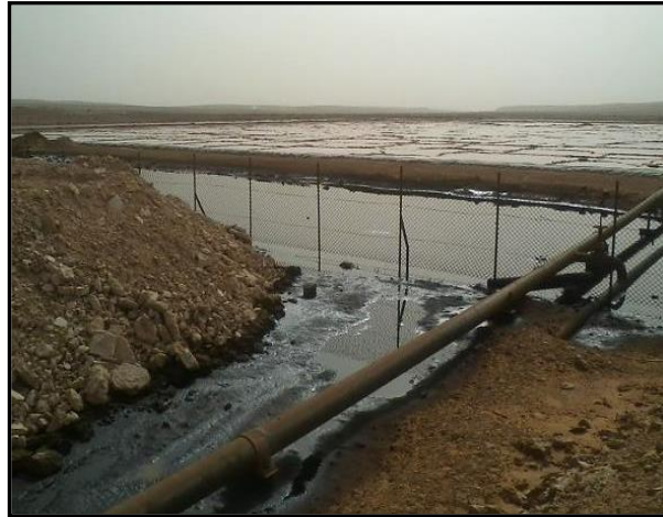
Fig.32: Puits-bourbier débordant.
