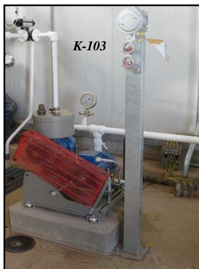
Fig.27: Les soufflants ' K-103 ' et les pompes de lavage ' P-118A/B '.
