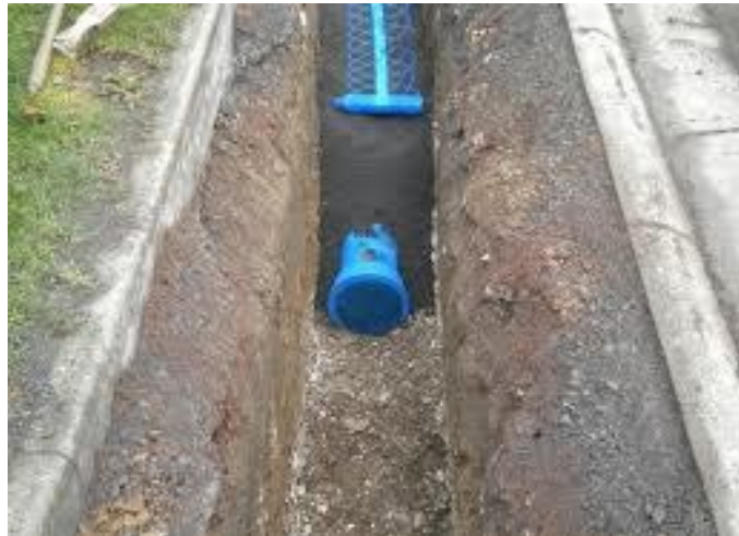
Figure N° 27 : Remblai des tranchées
