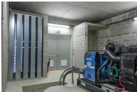
**Figure 170 :** local groupe électrogène
