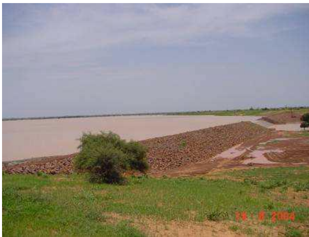
Digue en enrochement
