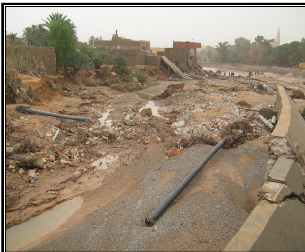
Le dégât causé par la crue d'Oct 2008 au niveau de Béchar centre (En face CFPA DEBDABA)
