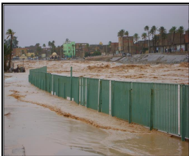
La crue d'Oct 2008 au niveau de Béchar centre (Aval du pont MIRASSOLI)
