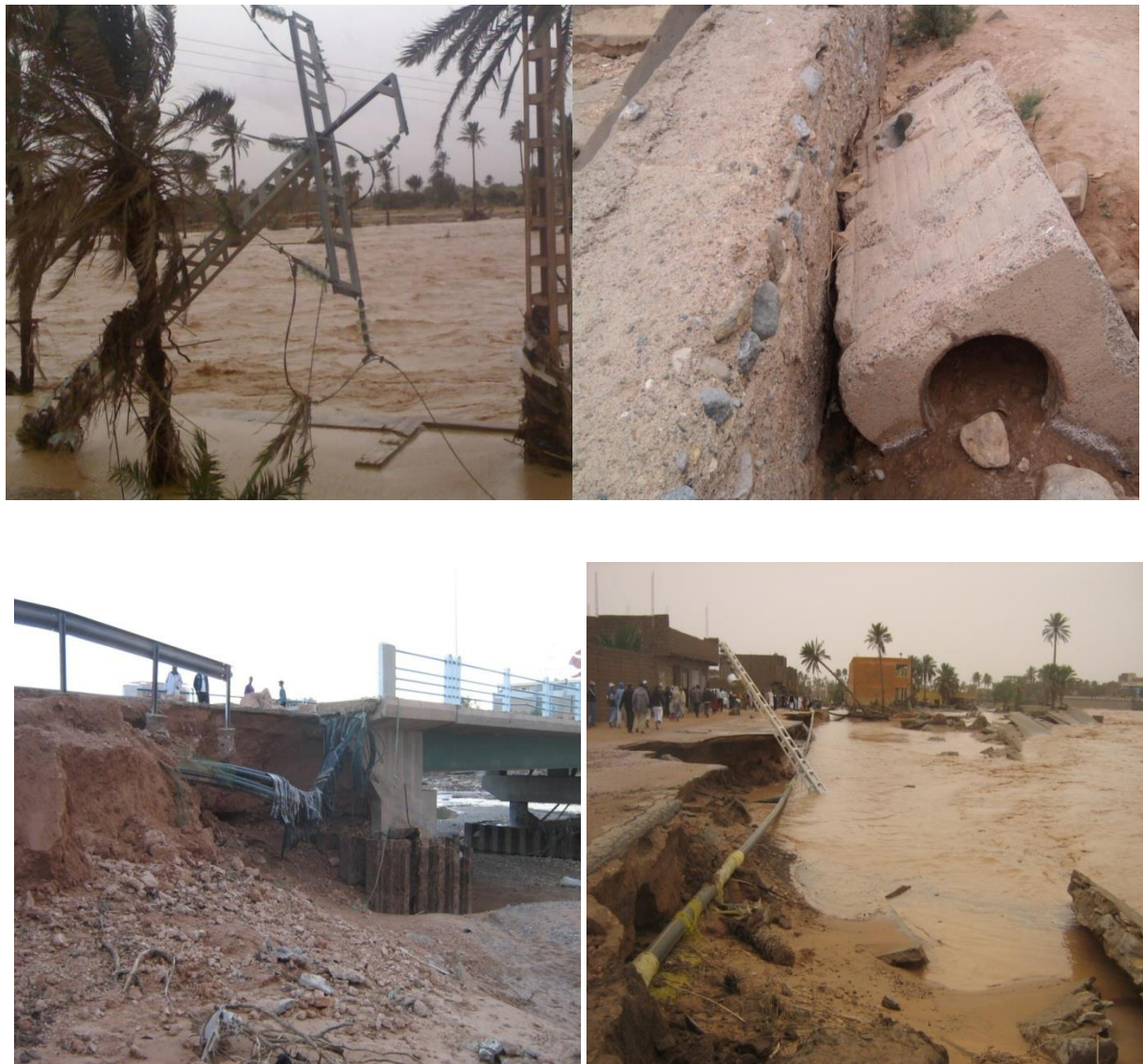
Figure I.6: Dégâts causée par l'inondation
