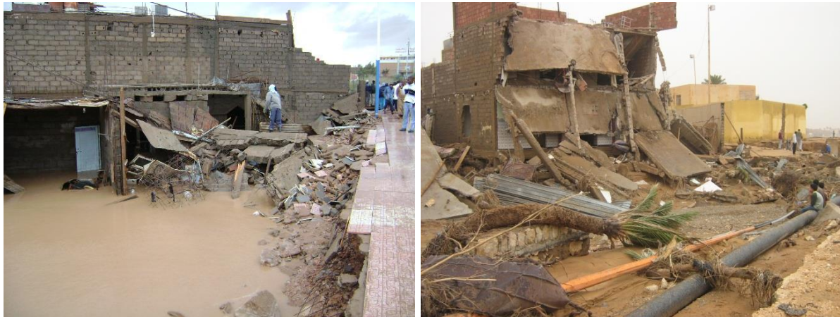
Figure 1.5 : Les dégâts du secteur du logement (quartier Mezarrif) (Halilou 2011)
