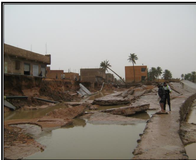
Le dégât causée par la crue d'Oct 2008 au niveau de Béchar centre (NAI ELNOUR ou quartier Huit)
