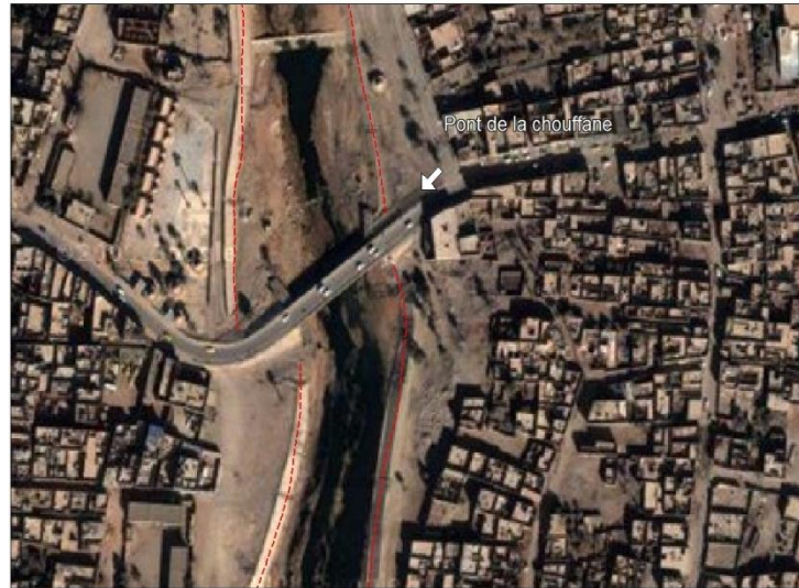
Figure I.3: L'engorgement au niveau du pont la Chouffane (Halilou 2011)
