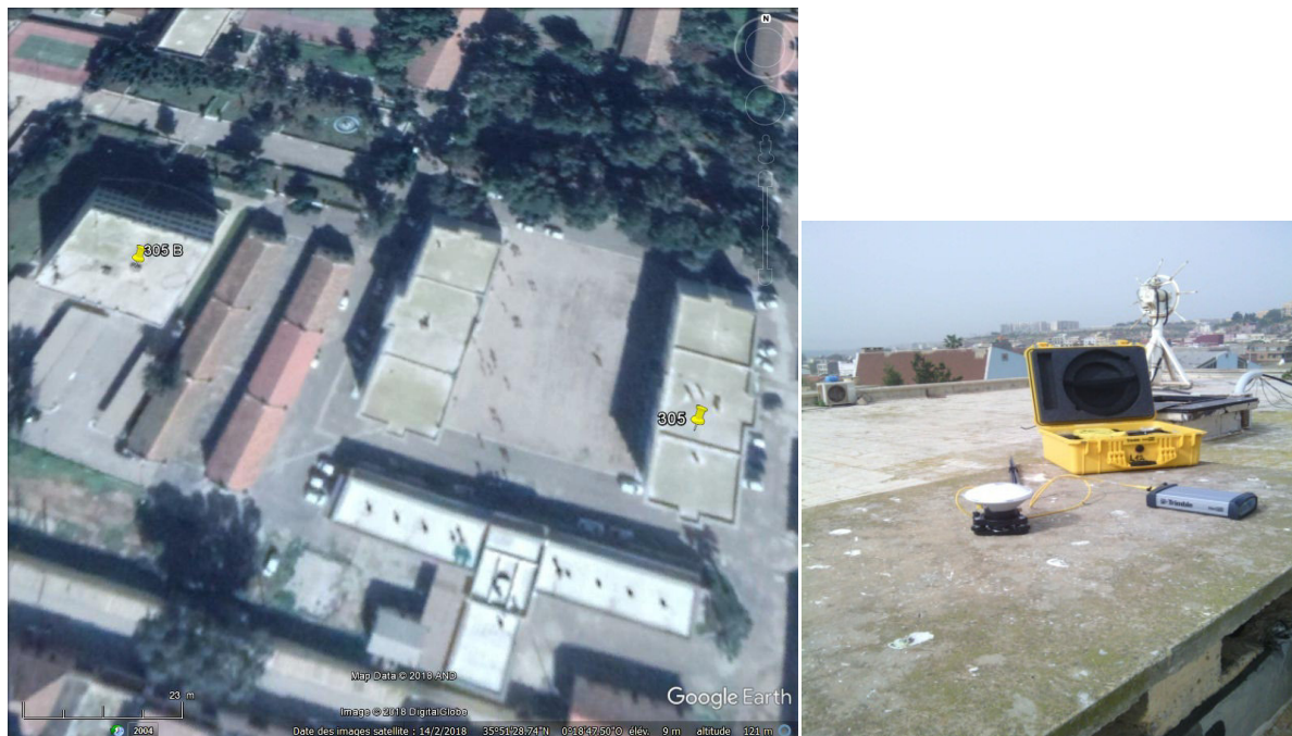
FIG. IV.2. Visualisation globale des sites 305 et 305 b sous Google Earth (à gauche) avec la mise en place du matériel sur le site 305 b (à droite) lors du test effectué sur le toit du CTS (13 mars 2018)
