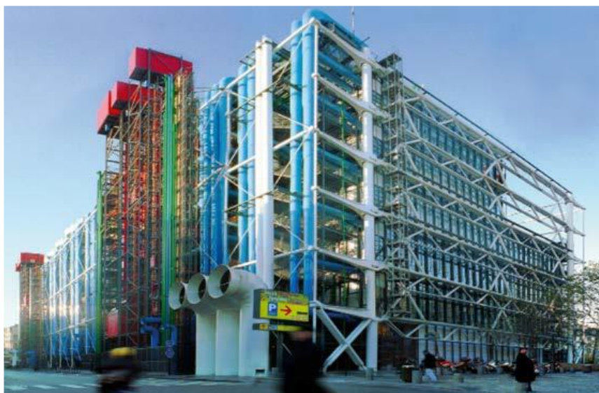
Figure 18 : Traitement de façade du centre de pompidou
