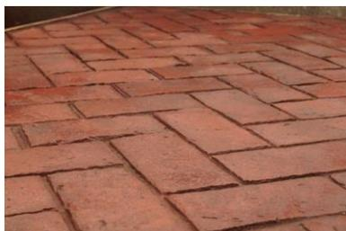
**Figure212 :** Pavé en béton imprimé en forme de brique rouge
