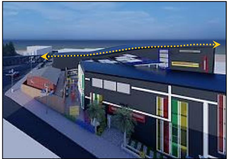
Figure 159: toiture en panneaux sandwich dans le projet
