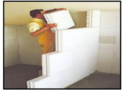
**Figure 163 :** des cloisons en béton cellulaire. **Source :** Google image
