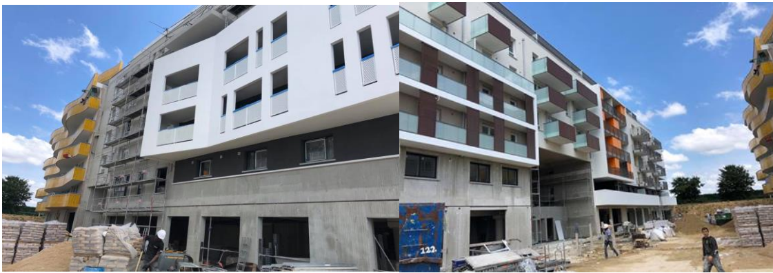
Figure 2-18 : Image montrant les bâtiments en construction.
