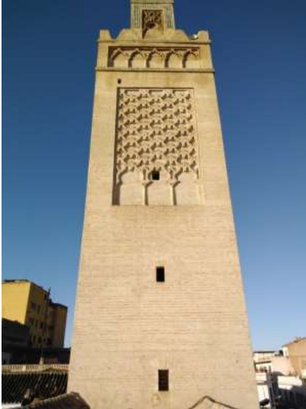
الواجهة الجنوبية لمئذنة الجامع الكبير
