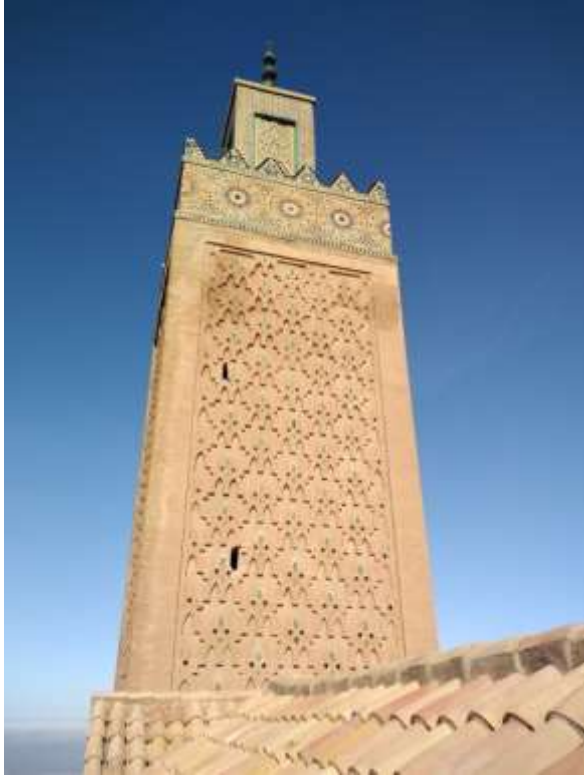
الواجهة الشمالية لمئذنة سيدي أبي مدين
