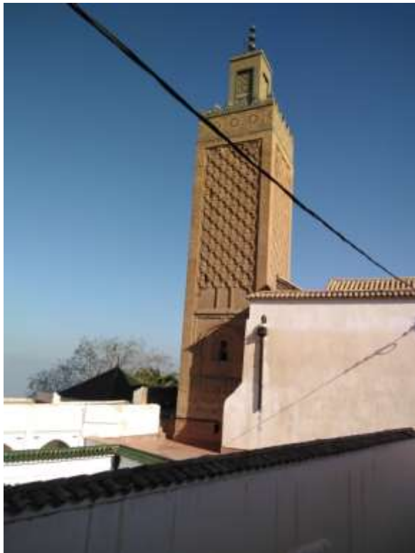
الواجهة الجنوبية لمئذنة سيدي أبي مدين
