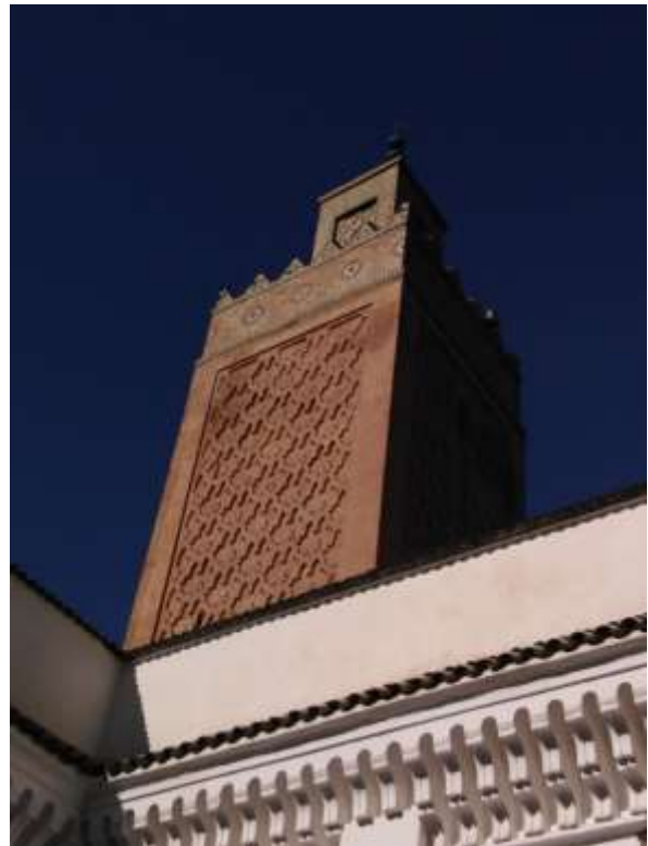
الواجهة الجنوبية لمئذنة سيدي أبي مدين
