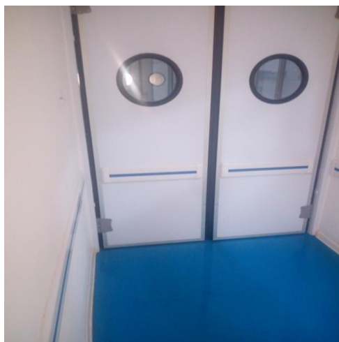
Figure 44 : Porte d'entrée des malades vers salle opératoire.
