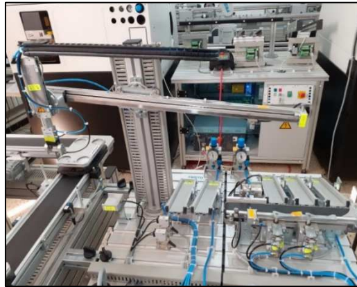
Figure II. 34 : Station de livraison.
