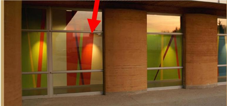
Façade qui combine des murs courbés en pisé avec des murs rideaux en RDC et l'étage vitré ,et une toiture courbée .
