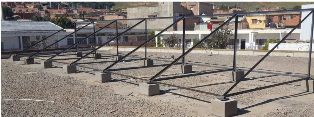
Figure 2-8 : Supports des panneaux solaires.
