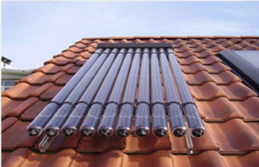
**Figure 1-33:** Capteur à tube sous vide [49].
