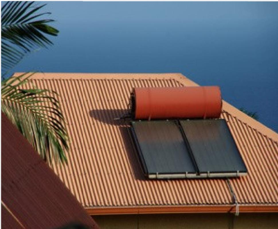
**Figure 1-32:** Capteur plan [47].
