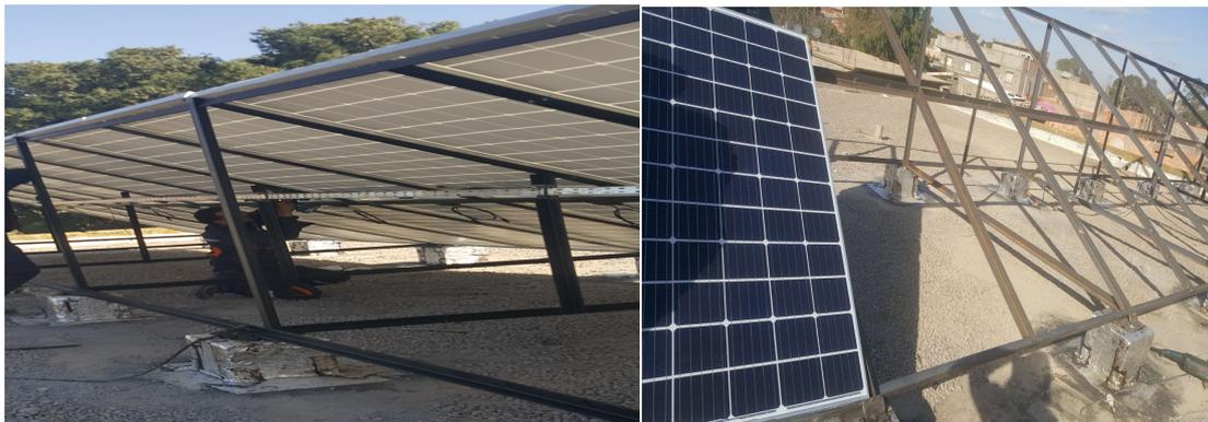
Figure 2-9:La pose des panneaux.
