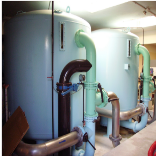
FIGURE 1.4: Cuves de filtration à sable
