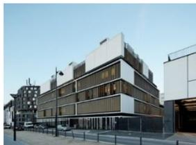
Les éléments extérieurs en béton blanc préfabriqués sont réalisés à base de ciment blanc à effet photo catalytique qui confère au béton un caractère autonettoyant
