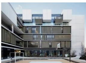
Entre les rubans en béton blanc se développe un jeu de volets en aluminium dorés qui permet de moduler les ouvertures
